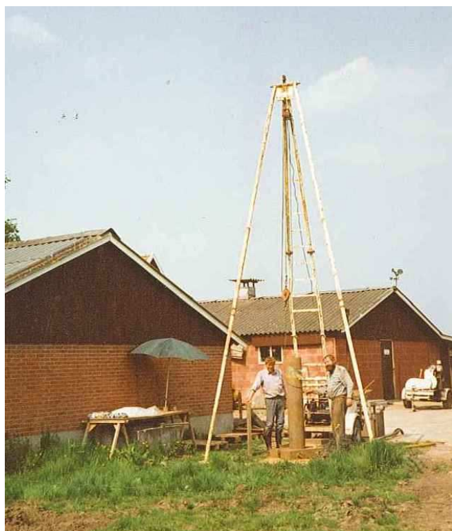
Figuur 4 Pulsaboring voor particulier, zomer 1990
